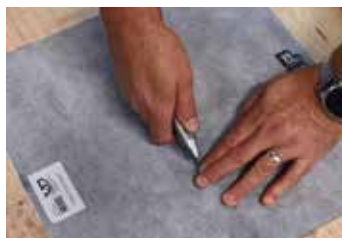
3. Håltagning av tätskikt. Placera 2 fingrar från kanten av brunnens innansida och skär 2 stk kryss.
