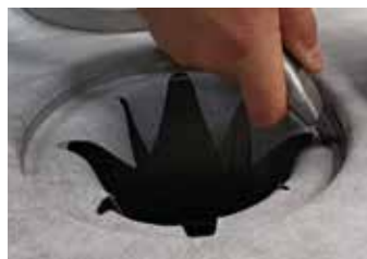
8. Skär bort överflödet av tätskikt
