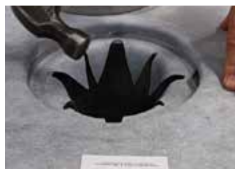
7. Slå fast klämringen. Slå med bestämda slag på expansionskarven. Vid behov, justera klämring med silen.
